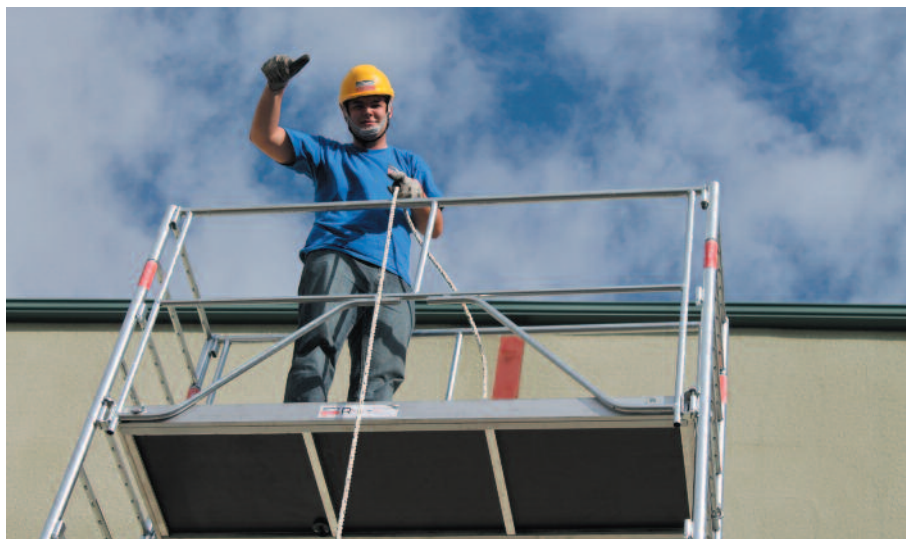
Matériaux et outils hissés avec des moyens adaptés permettent de garder les mains libres.
