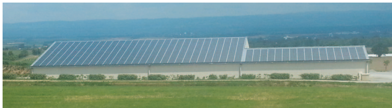
Le développement des toitures photovoltaïques entraîne de nouveaux risques émergents à prendre en compte dans les projets.
