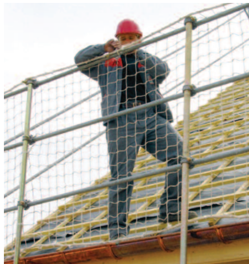
Pose de protections jointives périphériques en bas de pente.
